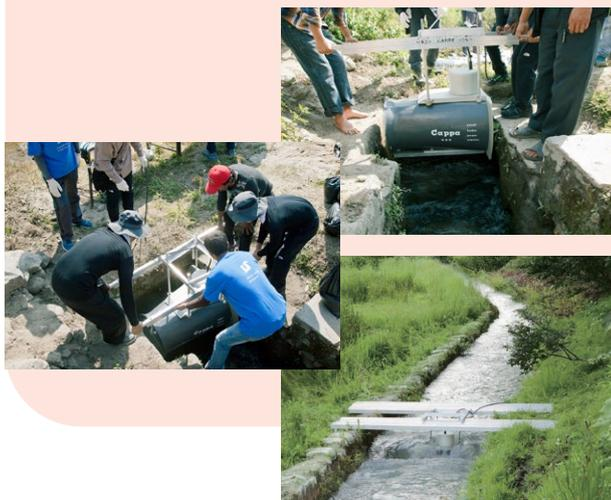
水の流れて沈めるだけで発電が開始できるため、大型の重機は必要なく山奥やアクセスの悪い場所でも設置することが可能です。博士曰く、持続可能な社会を実現するためにも、これからのエネルギーは従来のダムのように自然を大規模に制御するのではなく、自然に負荷を与えずに知恵と技術で自然の力を引き出すことが必要であると。
